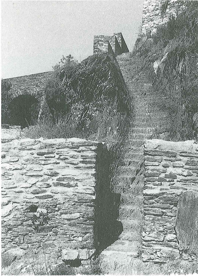
Die Felstreppe mit der „Küchenpforte“ als kürzeste Verbindung zwischen Hauptweg und Oberburg
