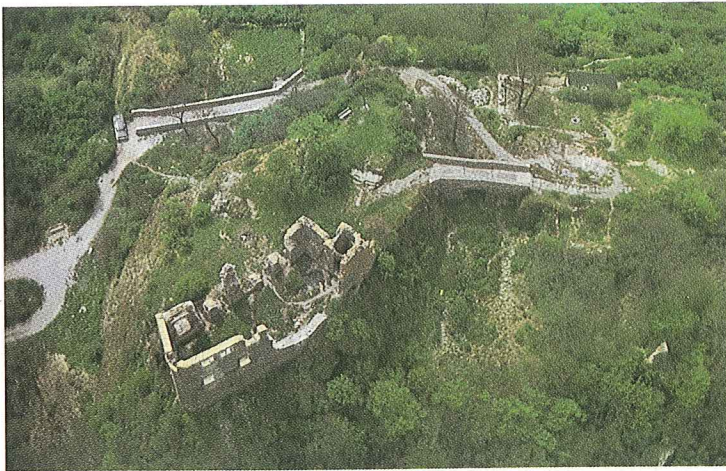
Blick auf die Oberburg und ihre Zuwege mit den Brücken über den unteren und oberen Burggraben
